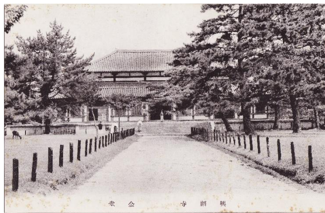
昭和 20 年頃の中金堂（仮堂）
