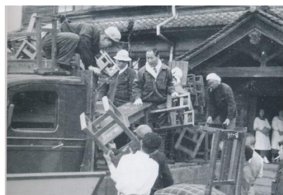
昭和 32 年(1957)鉄筋 3 階建て校舎完成. 父兄の皆様も引越し手伝い
