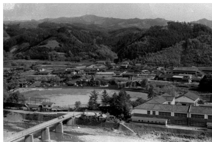
グラウンドと上市橋
