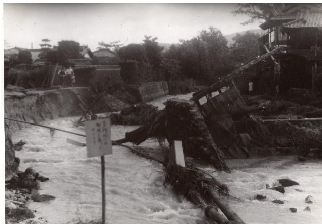
法蓮橋の流失物
