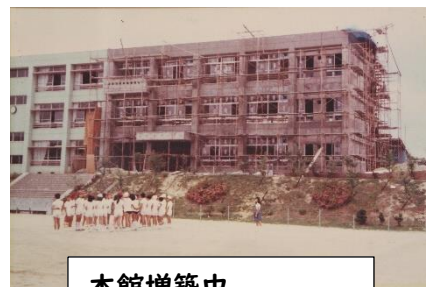
本館増築中 写真：右京小学校
