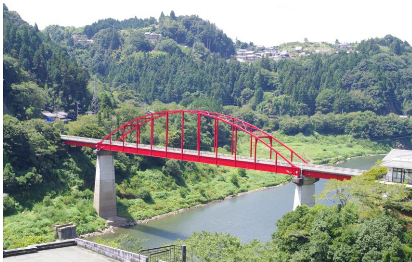
現在の月ヶ瀬橋
