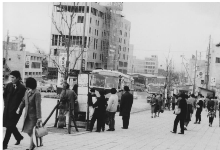
建設中の奈良近鉄ビル 地下駅建設中
