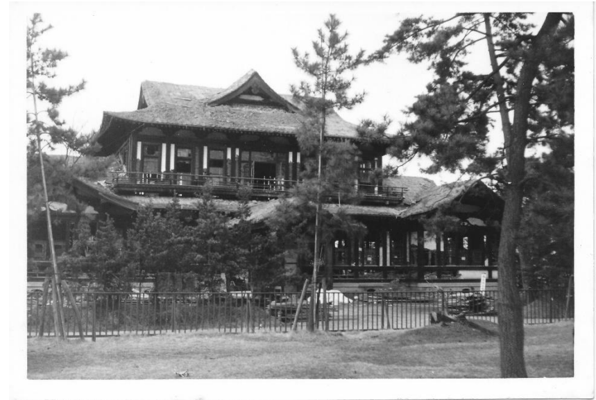
昭和 43 年 県立奈良図書館移築工事中(奈良公園内) 写真：吉田守氏
