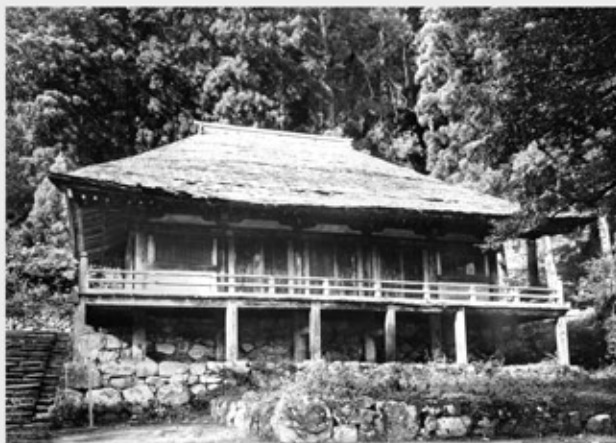
国宝 室生寺金堂 修理前
