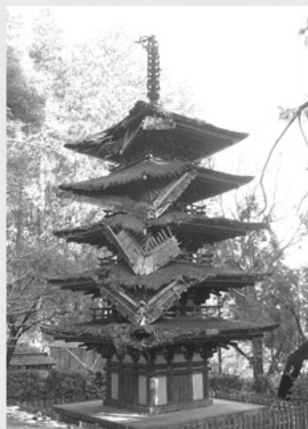
国宝 室生寺五重塔 修理前
