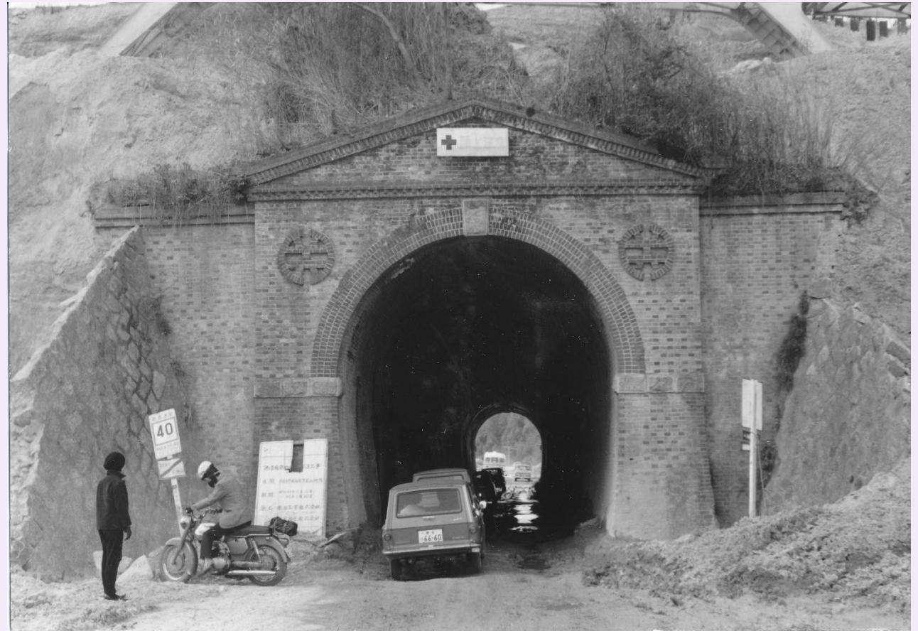
旧関西鉄道大仏線黒髪山トンネル(奈良側) 取壊し工事中 山は削られ、新し鉄橋の橋脚が見える。
