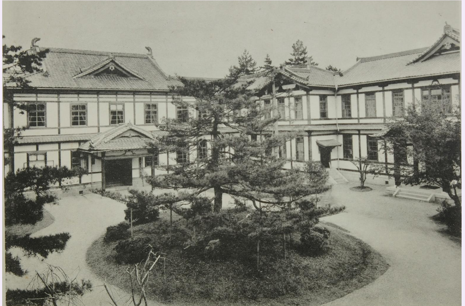
明治 28 年に新築された奈良県庁舎
