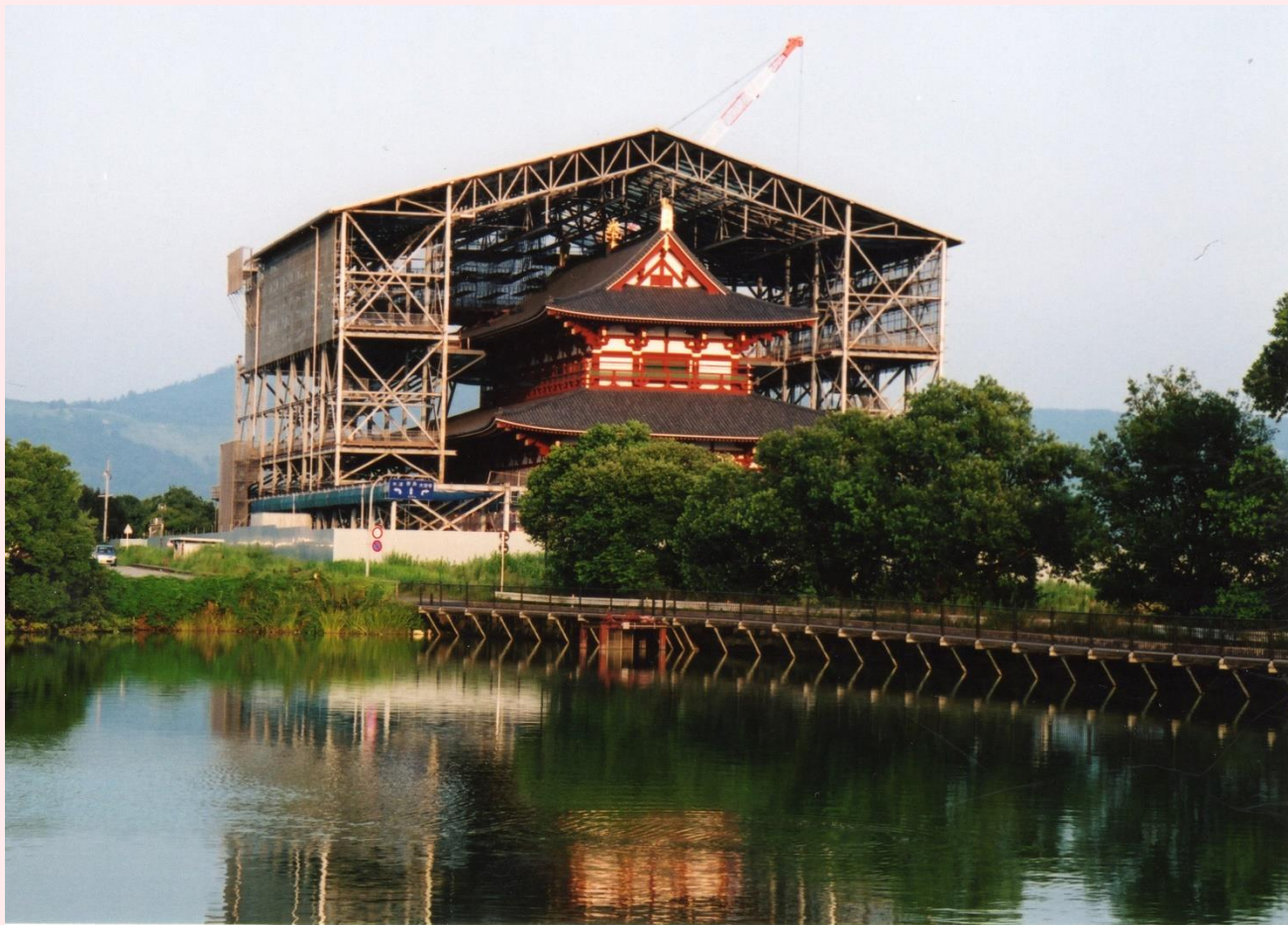
平成 21 年 (2009) 8 月 第一次大極殿大極殿建設中
