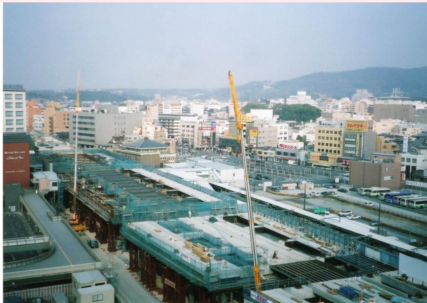
平成 19 年（2007） 高架工事中新奈良駅舎 中央左側は旧駅・右は仮駅舎
