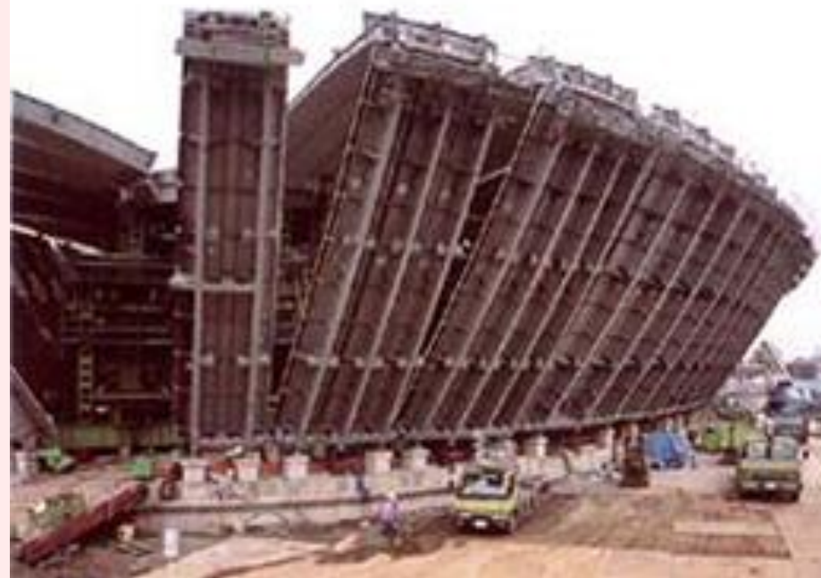
100年会館建設中 写真提供：100年会館
