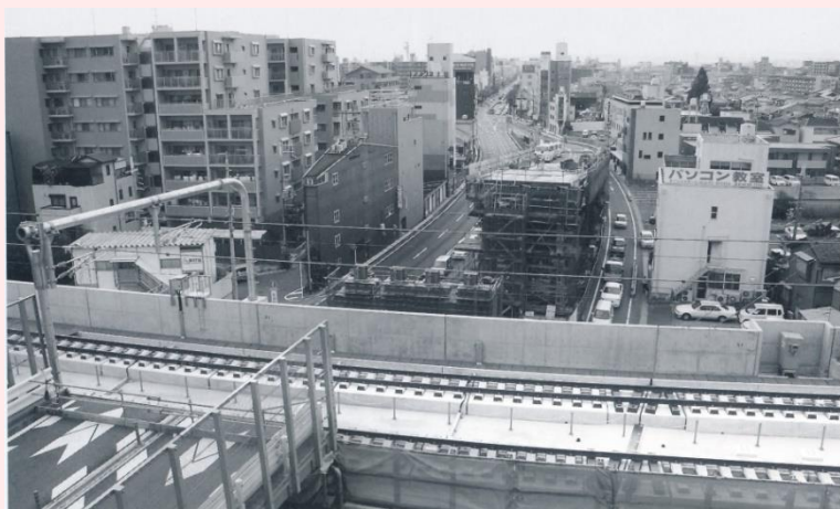
大宮跨線橋取り外しと JR 線開通
