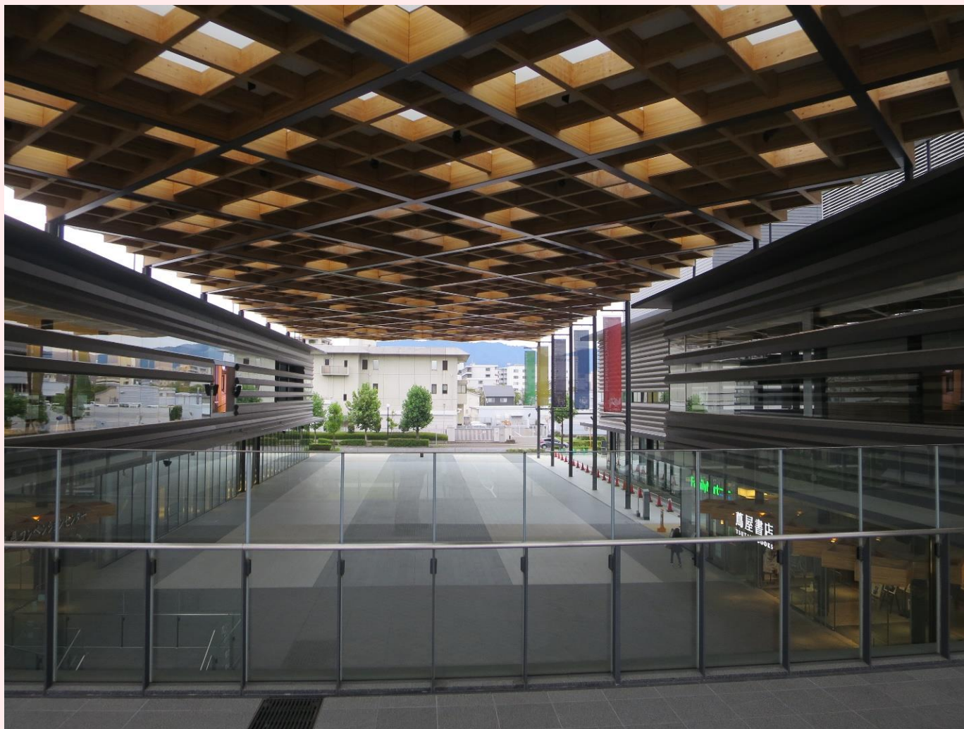
「天平広場」大きな屋根がついた屋外広場 奈良県産材の木材を活用した格子梁で天平文化を表現
